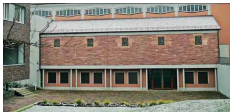
Der tiefer liegende Vorhof der Kirche mit Zugang zum Gemeindesaal.
